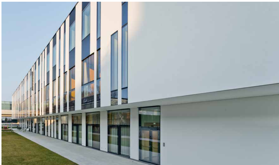
Bild rechts, links: GZD – Geriatriezentrum Donaustadt, Wien, AT Architekt: Delugan Meissl, Wien, AT Verwendete Produkte: StoVentec R, Oberputz Miral MP mit StoColor Lotusan® Foto: Christian Schellander / Sto
