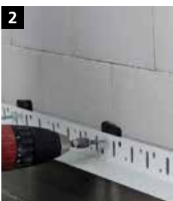
2 Sto-Startprofil PH-K entsprechend der Sockelhöhe mit Sto-Schlagdübeln S UEZ 8 befestigen. Die Dübel im Abstand von max. 30 cm anbringen. Wandunebenheiten mit Sto-Unterlegscheiben ausgleichen. Den Spalt zwischen Sockelleiste und Wand mit Sto-Pistolenschaum SE schließen. Zur Verbindung der Sockelprofile Sto-Sockelleistenverbinder L verwenden. Die Verbinder passend zuschneiden. Im Eckbereich Startprofil auf Gehrung schneiden.
