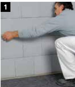
1 Vor Beginn der Verlegearbeiten die Sockelhöhe festlegen und mit einer Richtschnur markieren. Anschließend den Sockelbereich vorstreichen mit StoFlexyl, 1:1 mit Zement angemischt und mit 10 % Wasser verdünnt.
