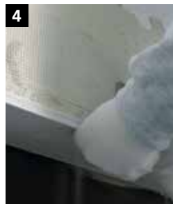
4 Sockelprofil mithilfe des integrierten Selbstklebendes auf der Unterseite der ersten Dämmplattenreihe fixieren.
