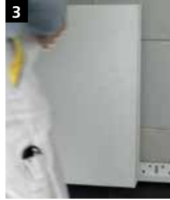
3 Fassadendämmplatten auf das Startprofil aufsetzen.
