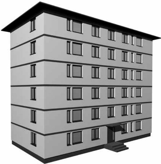
Umlaufende Brandschutzbänderole bei einem mehrgeschoßigen Gebäude.
