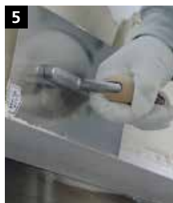
5 Gelochten Schenkel und integrierten Gewebestreifen des Sockelprofils in den noch feuchten Unterputz einbetten. Anschließend erfolgt die Flächenbewehrung wie bei Variante I.
