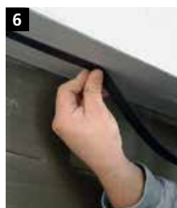
6 Auf der Unterseite des Sockelprofils Sto-Fugendichtband Lento aufkleben. Anschließend den Sockel dämmen.
