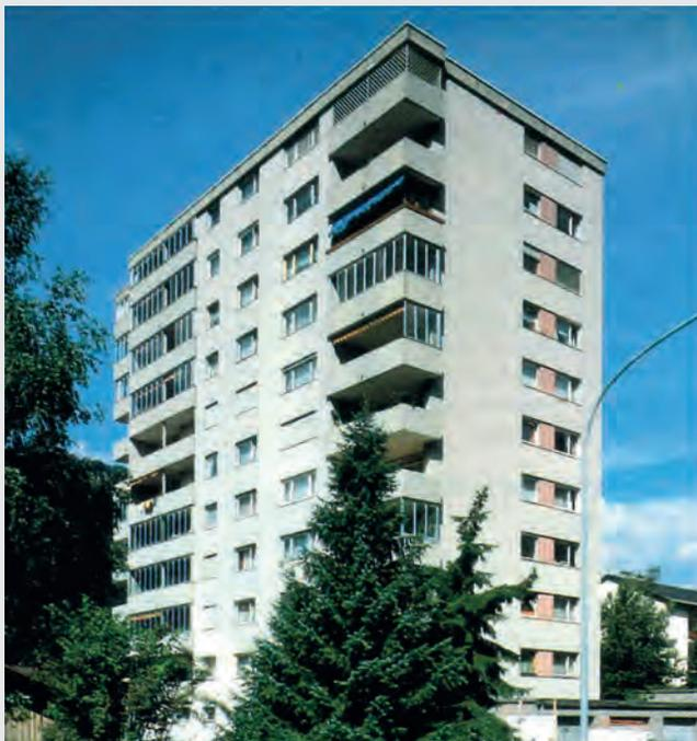
Zur Vorgeschichte: Im Jahre 1969 wurde in der Mutterstraße 64 in Feldkirch ein elfgeschossiges Hochhaus mit Eigentumswohnungen errichtet. Die ganze Fassade wurde mit dem Wärmedämm-Verbundsystem K von Sto – heute StoTherm-Classic – ausgestattet und mit
