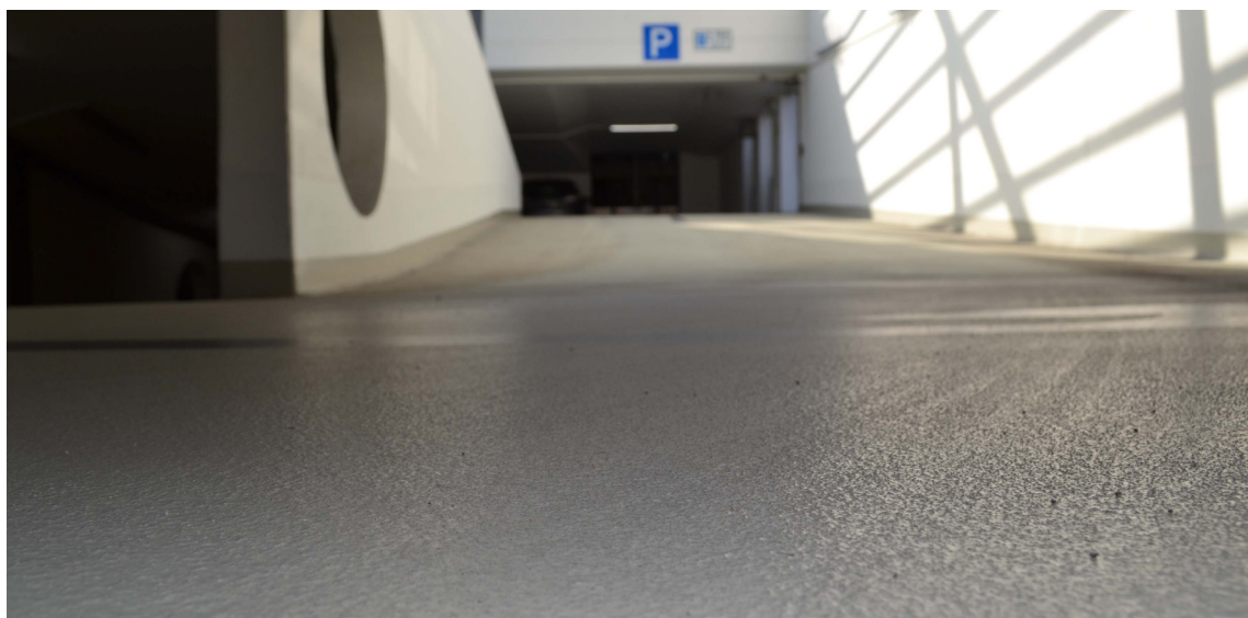
Parkeergarage, Kirchheimbolanden, Duitsland Expertise van Sto: systemen voor oppervlaktebescherming Foto: Sto
