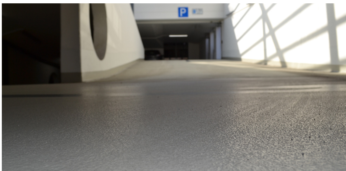
Parking couvert, Kirchheimbolanden, DE Compétences Sto : systèmes de protection des surfaces Photo : Sto
