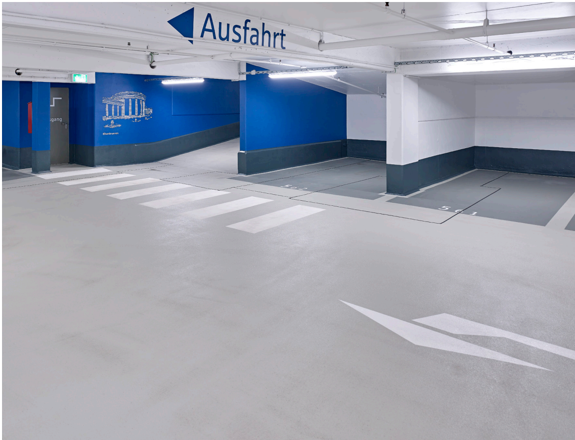
Parking souterrain de la Sparkasse, Aix-la-Chapelle, DE Compétences Sto : systèmes de protection des surfaces Photo : Guido Erbring
