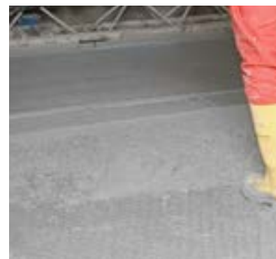
Einbettung und dauerhafte Ankopplung der Anode mit geeigneten Mörtelsystemen
