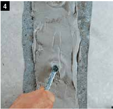
4 Kegelnippel einschrauben
