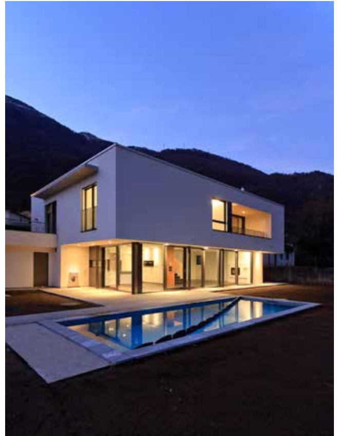
Zweifamilienhaus in Mezzovico, StoTherm Vario
