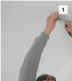
**1** Zur Erstellen einer Schattenfuge mittels Laser eine gerade Verlegelinie projizieren. Während der Verarbeitung sollte der Laser eingeschaltet bleiben.
