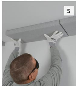
**5** Beim Ansetzen der nächsten Akustikplatten sollten die bereits verklebten Akustikplatten mit der Hand gestützt werden, um ein Verschieben zu vermeiden.
