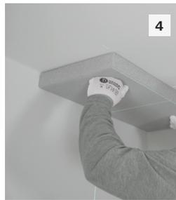
**4** Die Akustikplatte StoSilent Board R 400 an die Deckenkante anstossen, ausrichten und gleichmässig andrücken.
