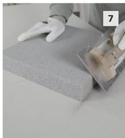
Nach dem Zuschnitt der Platten muss bei der Schnittkante eine nachträgliche Fase manuell erstellt werden. Hierfür die Kanten mit dem Sto-WDVS Schleifbrett im 45° Winkel vorsichtig anschleifen. Alternativ kann hierzu die Fase auf einer Tischkreissäge oder mit der Handkreissäge fachgerecht geschnitten werden.
