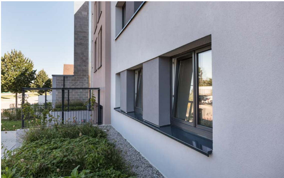
Objekt: Seeleben, Kenzingen, DE Die durchlaufende Fensterbank verknüpft Fensteröffnungen sowie Fassadenflächen unterschiedlicher Dämmstoffdicken
