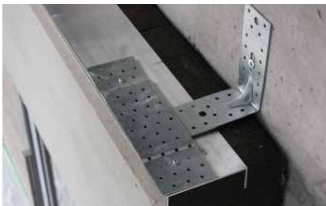
Die Montage mithilfe der Metallwinkel und der Sto-Montagebügel JAK ist sehr einfach.
