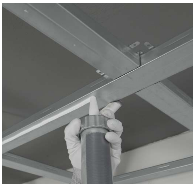
Kleberauftrag mit der Klebepistole
