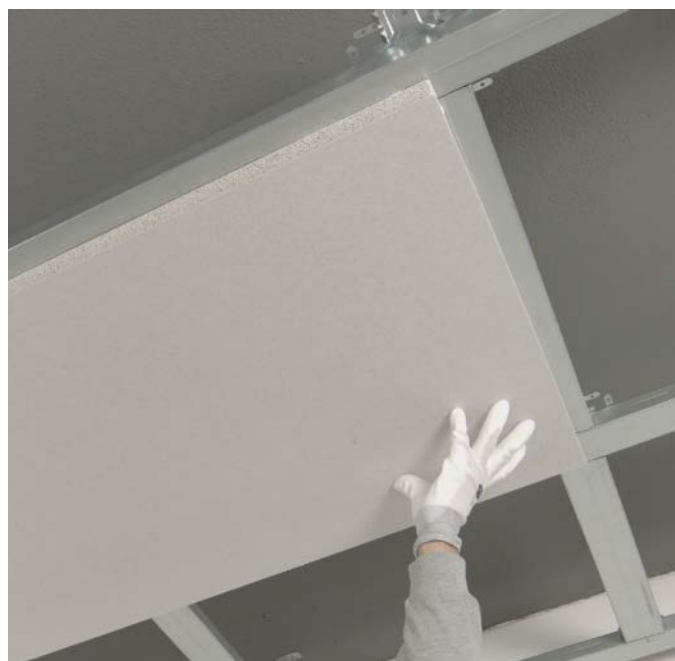
Andrücken der Akustikplatte
