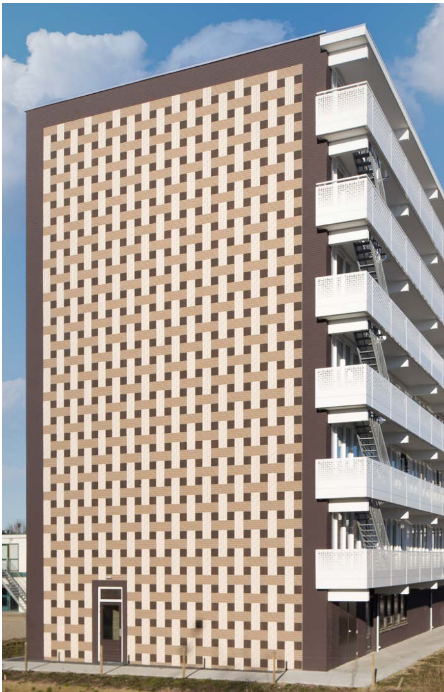
De Wever, Gennepe, NL Bauherr: Mooiland Wonen, Grave, NL Planung: 2.0 Architecten, Venlo, NL Ausführung: IJsselmonde VOF, Rotterdam, NL Sto-Kompetenzen: StoTherm Classic®, StoCleyer B, StoEcoShape Foto: Bona Pictura, Cuijk, NL
