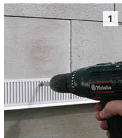
StoNordic pudslister kan monteres direkte på underlaget
