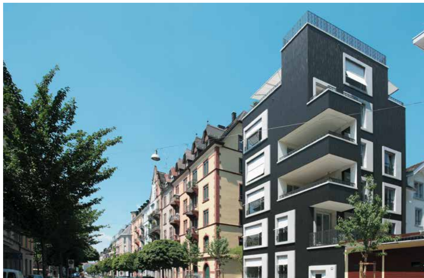
Byhus Zurlindenstraße, CH-Zürich; Arkitekt: huggenbergerfries Architekten AG, CH-Zürich; Foto: Beat Bühler
