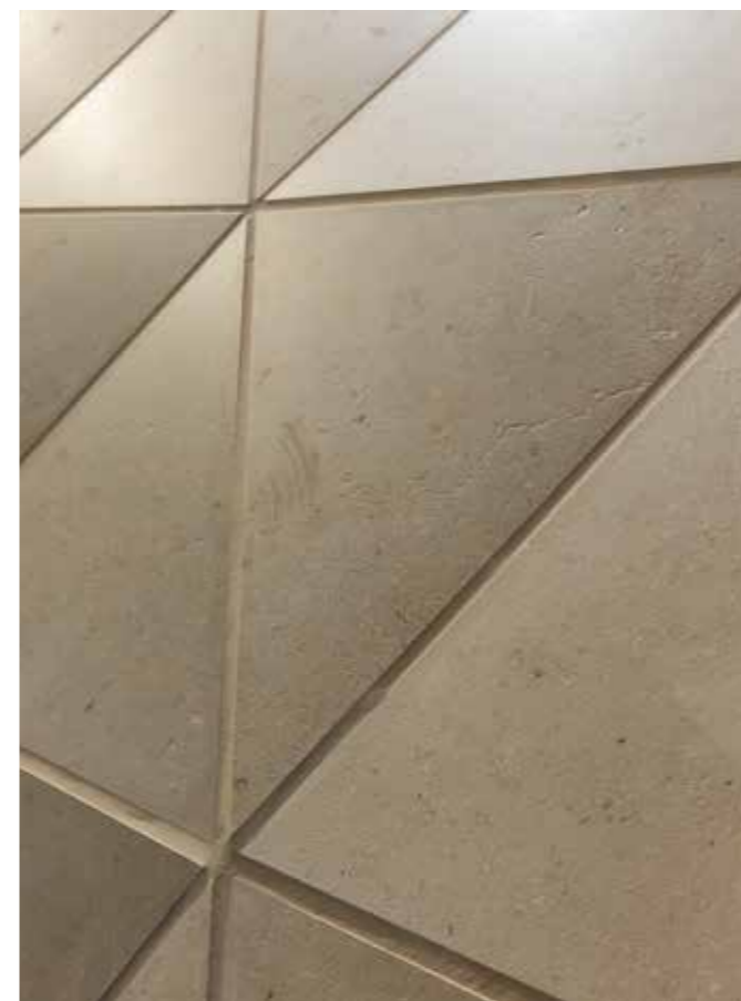
Detaljefoto af naturstensfliser, optimalt tilskåret en beklædning med frie former, og med farvede fuger som designelement.
