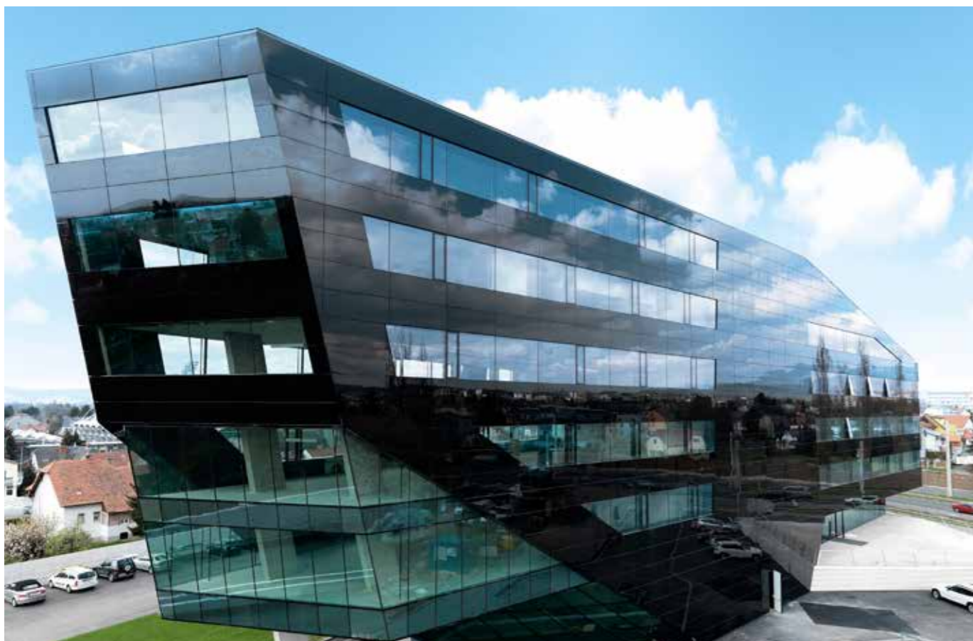
Kontor- og butikbygning MP09, AT-Graz; Arkitekt: GS architects, AT-Graz; Foto: Gerald Liebming
