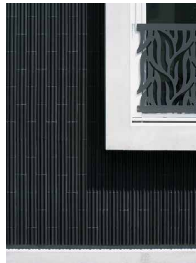
Materialeovergang fra sokkel og vindue til keramikfacade
