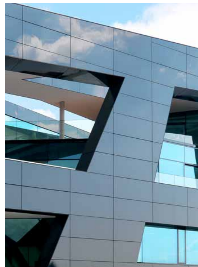
Overgang fra det sorte, usynligt monterede glaslement med åbne fuger til lysningen.
