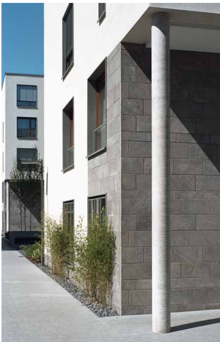
Immeuble collectif Q'Artis, Hanovre, DE Maître d'ouvrage : meravis Wohnungsbau & Immobilien GmbH, Hanovre, DE Planification : Lassen-Architekten, Gehrden, DE Mise en œuvre : Treffert GmbH, Alzenau, DE Compétences Sto : StoTherm Classic®, StoTherm Vario ; StoStone, pierre : Sto-Fossil SKL, poncé ; StoSignature, Texture: Rough 1 Photo : Christoph Gebler, Hambourg, DE
