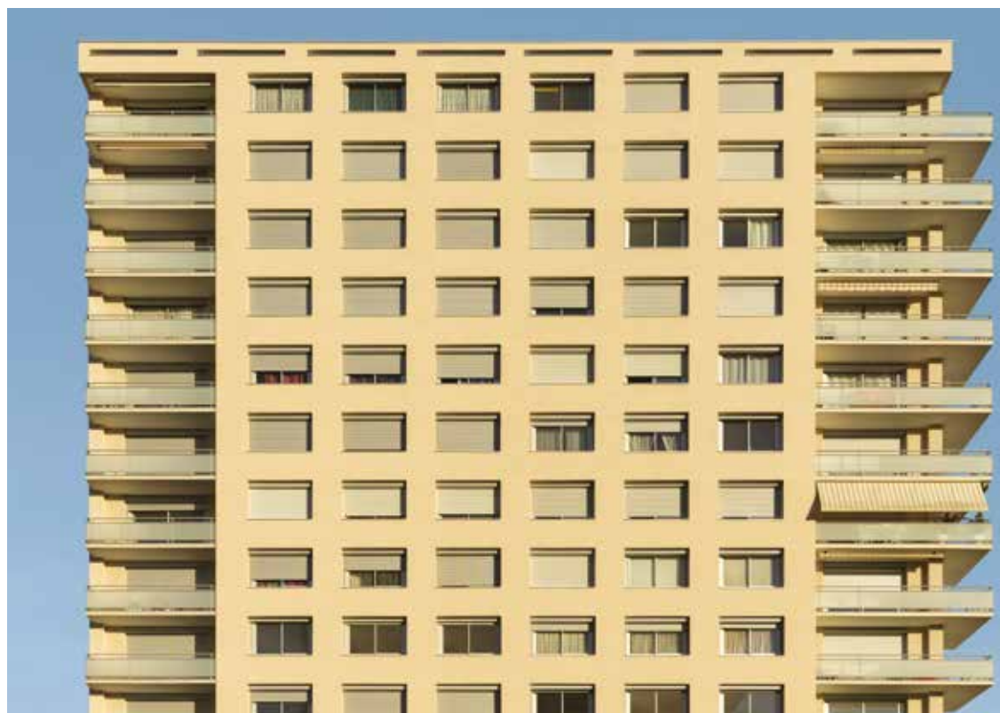
Ci-contre et ci-dessus : Résidences Fleuries, Bourg-en-Bresse Syndic de copropriété : Cabinet Boisson Economiste : Bemotech Système d'isolation thermique par l'extérieur sous enduit Crédit Photo : Aurélien Aumond
