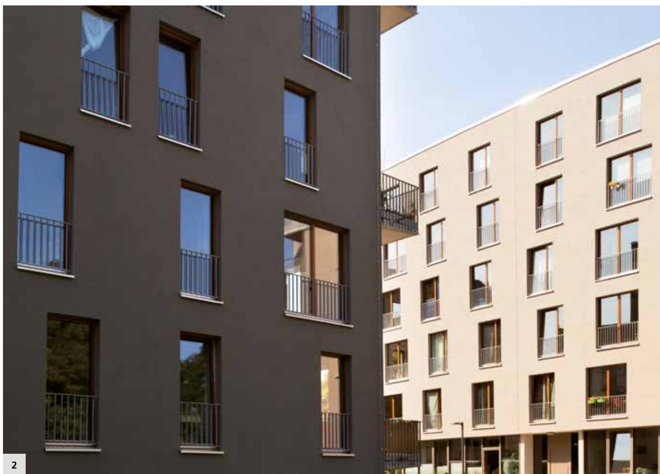
1 et 2. Immeuble résidentiel «Wohnen am Hochdamm» à Berlin (Allemagne). Solution Sto : StoTherm Mineral sur COB. Architecte : immologu. Architekten GmbH.
