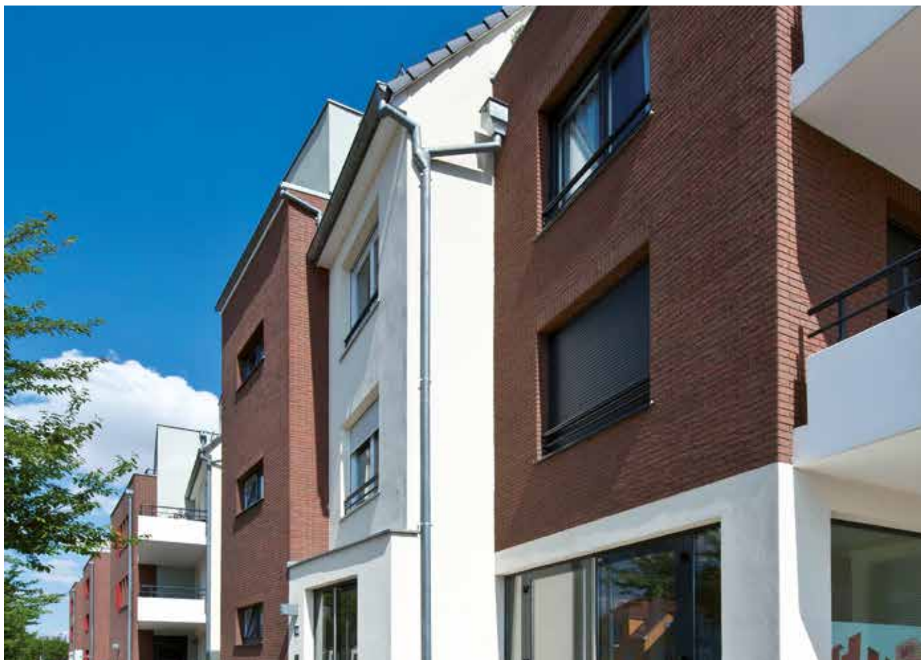
Logements collectifs sociaux à Ostwald. Solutions Sto : StoTherm Classic®, finition partielle Sto-Briquettes de parement. Bureau d'architecture : JB2L. Maître d'ouvrage : Habitation Moderne (67).
