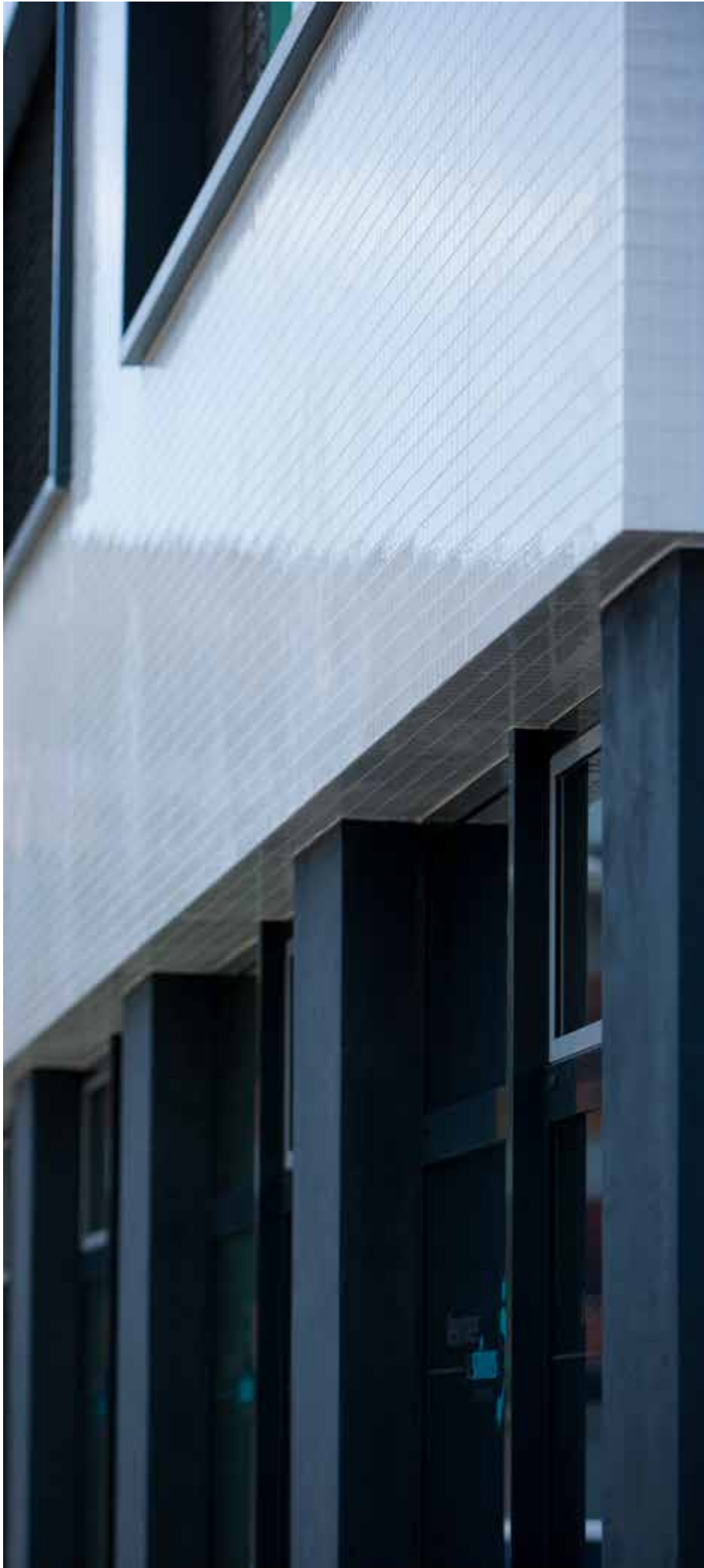
Centre de santé, Oberkirch, DE Maître d'ouvrage : Hurrle Beteiligungs GmbH & Co. KG, Oberkirch, DE Architecte : Müller + Huber Architekten, Oberkirch, DE Mise en œuvre : eble ausbau + fassade gmbh, Hohberg, DE Compétences Sto : StoTherm Vario ; StoGlass Mosaic Photo : Johannes Vogt, Mannheim, DE
