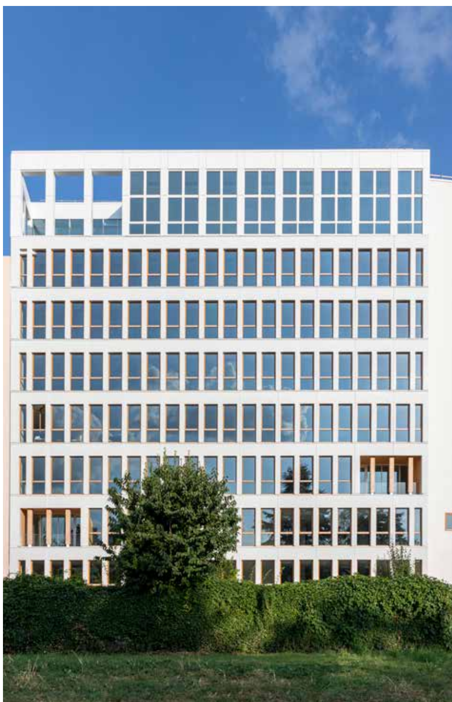
Bureaux "Green OAK", Arcueil (94), FR Maître d'ouvrage : Kaufman & Broad, FR Architecte : Agences Mootz Pelé et CALQ, FR Compétences Sto : système de bardage StoVentec SCM avec finition Glass Mosaic Photo : Manuel Panaget, FR
