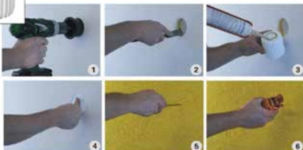
Per il fissaggio di elementi edilizi di medio carico (dai 9 a 18 kg), come discendenti, supporti in acciaio come mensole, esiste un elemento StoFix Zyrillo. Il posizionamento del carico avviene sempre tramite l'elemento di fissaggio. Non è richiesto l'ancoraggio del carico al supporto
