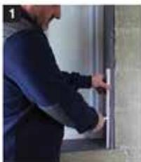
1 Misurate la posizione dello StoFix Trawik FK in funzione del posizionamento del cardine dell'imposta.
