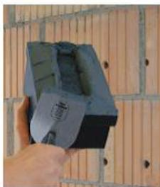
Applicate la malta collante alla superficie adesiva dell'elemento di fissaggio dello StoFix UMP-TRI
