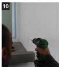
10 Una volta terminata la posa in opera del sistema, pre-forate al livello della posizione desiderata per il cardine dell'imposta.
