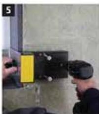
5 Pre-fissate lo StoFix Trawik FK al fine di permettere la regolazione dei piedi di fissaggio in un secondo tempo.
