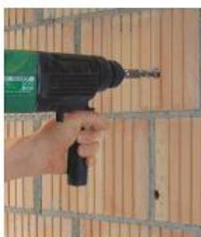
Segnare i fori per il trapano, trapanate, rimuovete la polvere della trapanatura, trapanate la muratura perforata senza impatto.
