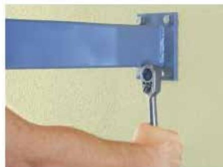
Avvitare l'elemento di fissaggio nello StoFix UMP-TRI.
