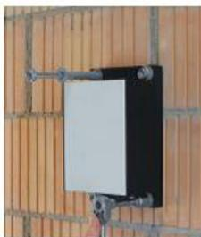
Inserite l'elemento di fissaggio StoFix UMP-TRI con vite ad avvitamento. Verificate che il tassello ad avvitamento fornito sia adatto per il supporto. Se questa non è adatta deve essere cambiata a spese dell'acquirente. Stringete il tassello ad avvitamento fino a quando l'elemento di fissaggio StoFix UMP-TRI non sarà posizionato in maniera che sia planare ed in aderenza al pannello isolante.
