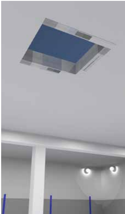
Forsterkning med laminat (StoFRP plate) og staver (StoFRP Bar) ved hulltaking.
