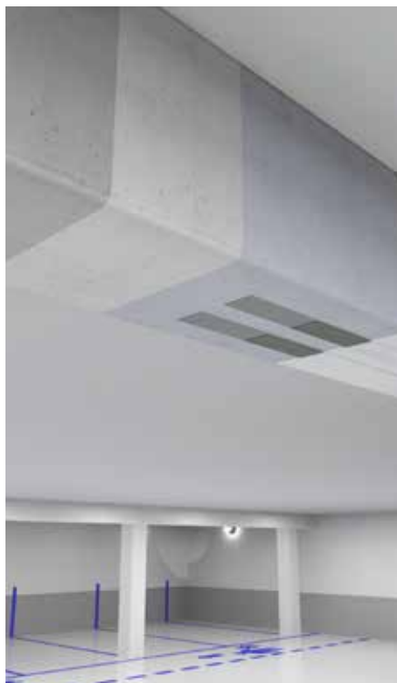
Forsterkning av bjelke med laminat (StoFRP Plate). Kan også være aktuelt med staver (StoFRP Bar) eller en kombinasjon av begge.
