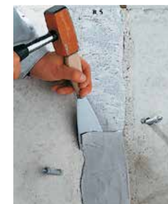
5. Usunięcie szpachli i iniektorów.
