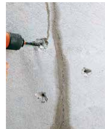
1. Wykonanie nawiertów obustronnie wzdłuż rysy pod kątem 45°.
