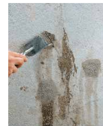
6. Zamknięcie otworów przez szpachlowanie.
