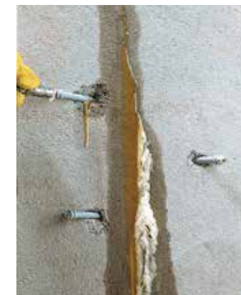
3. Wstępne wypełnienie rysy szybkościeniającym materiałem StoJet PU VH 200.
