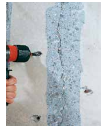
1. Wykonanie nawiertów obustronnie wzdłuż rysy pod kątem 45°.
