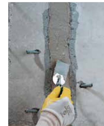
3. Powierzchniowe szpachlowanie rysy.
