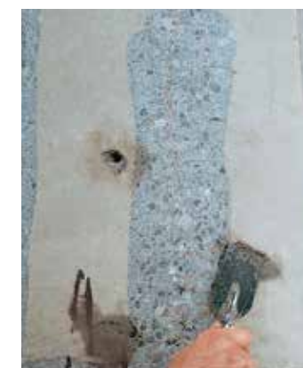
6. Zamknięcie otworów przez szpachlowanie.
