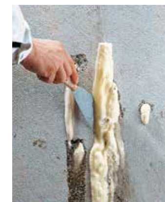
5. Usunięcie piany i iniektorów.
