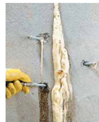
4. Iniekcja docelowa materiałem StoJet PIH 200 prowadzona na tych samych iniektorach.
