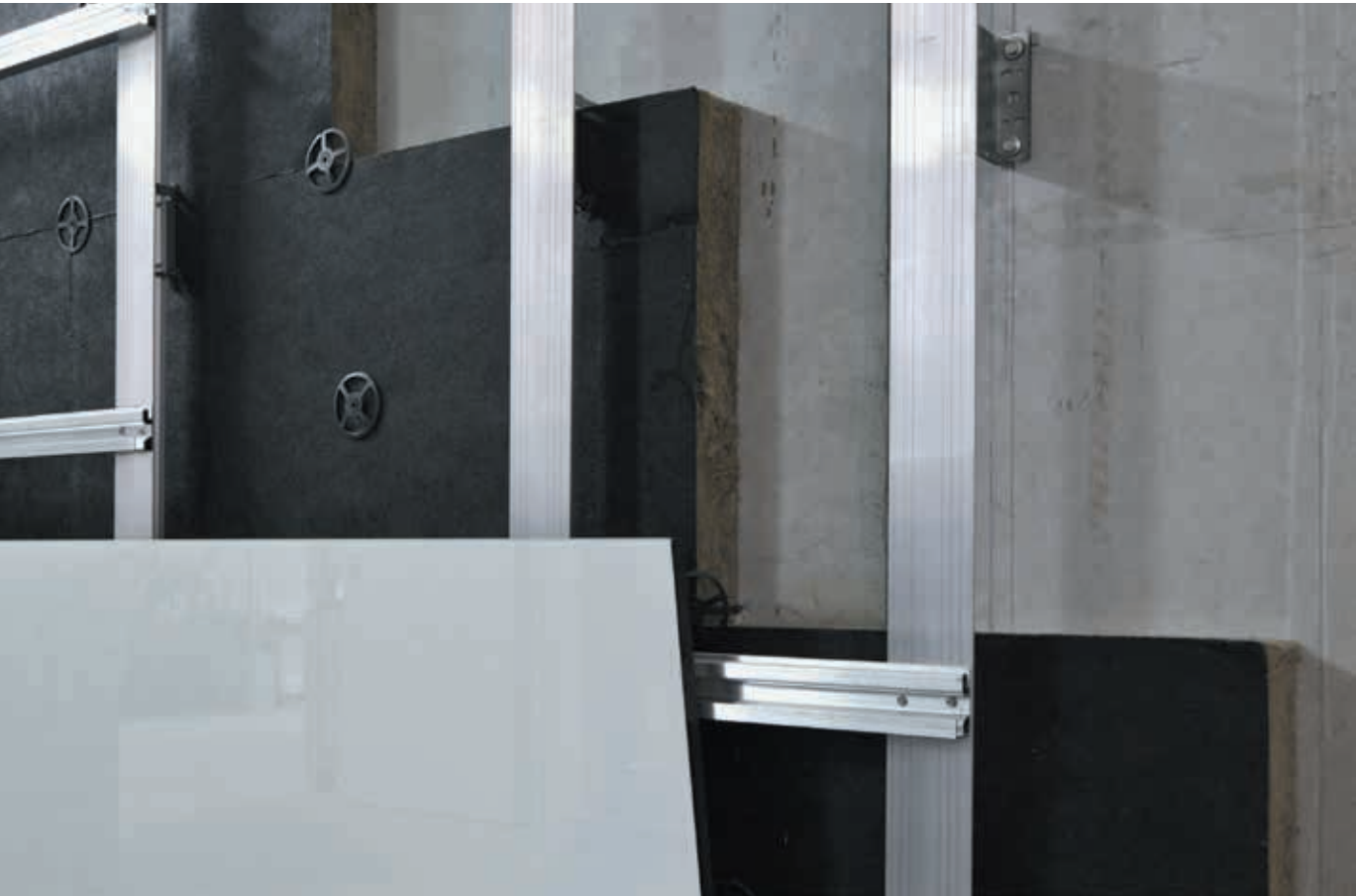
Budowa systemu StoVentec z podkonstrukcją ze stali nierdzewnej i aluminium
