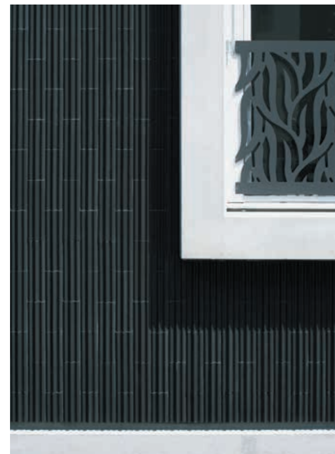
Cokół oraz obramowanie okna w połączeniu z okładziną ceramiczną
