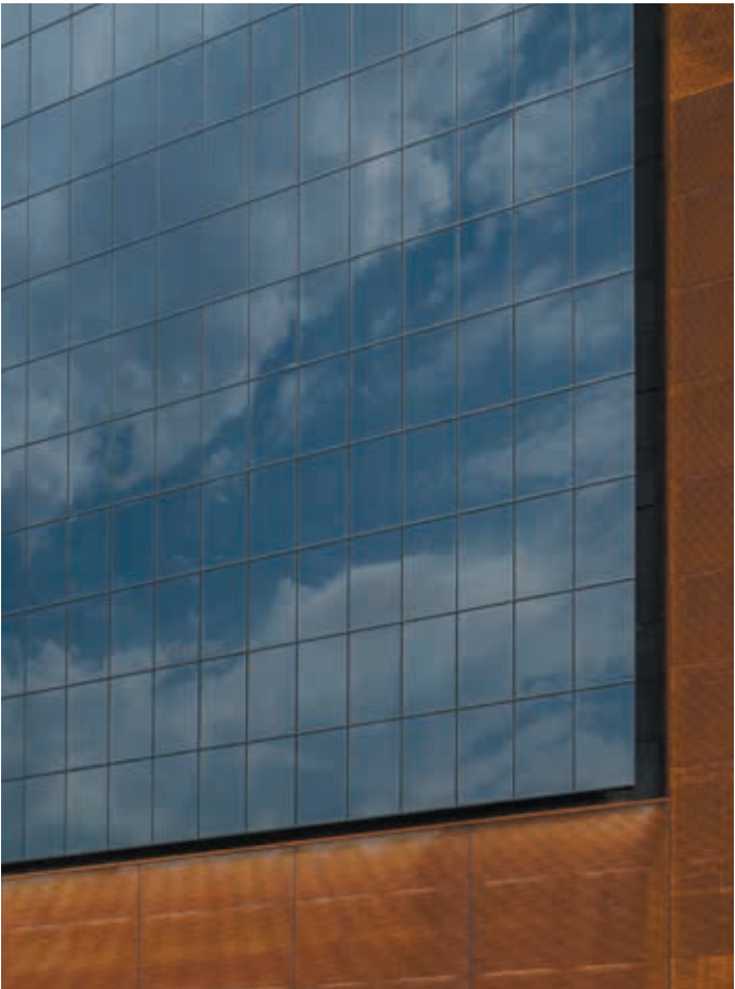
Obramowanie fotowoltaicznych elementów elewacji
