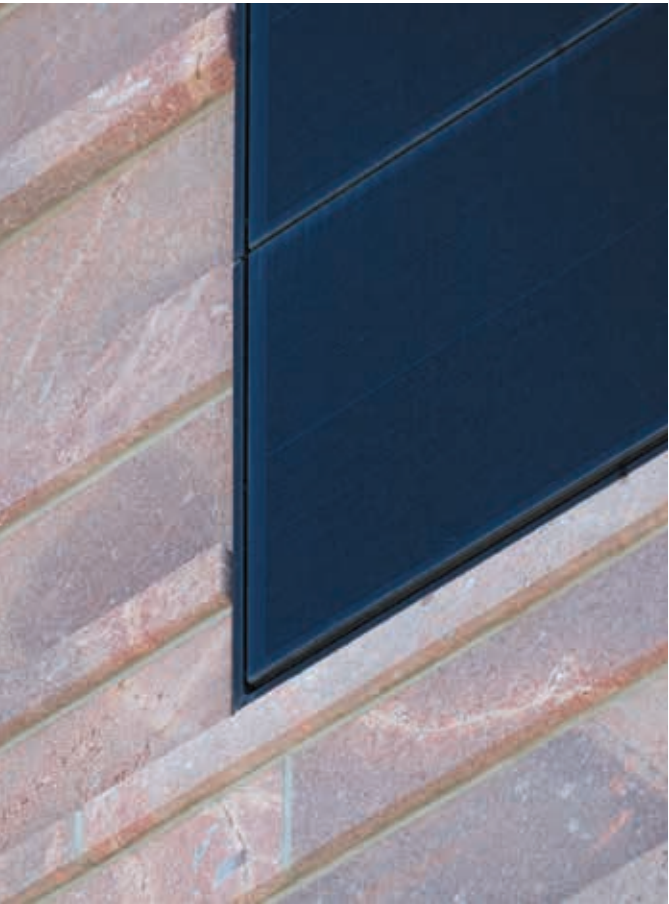
Panel fotowoltaiczny wkomponowany w elewację z kamienia naturalnego Kościół St. Trinitatis, Lipsk, Niemcy
