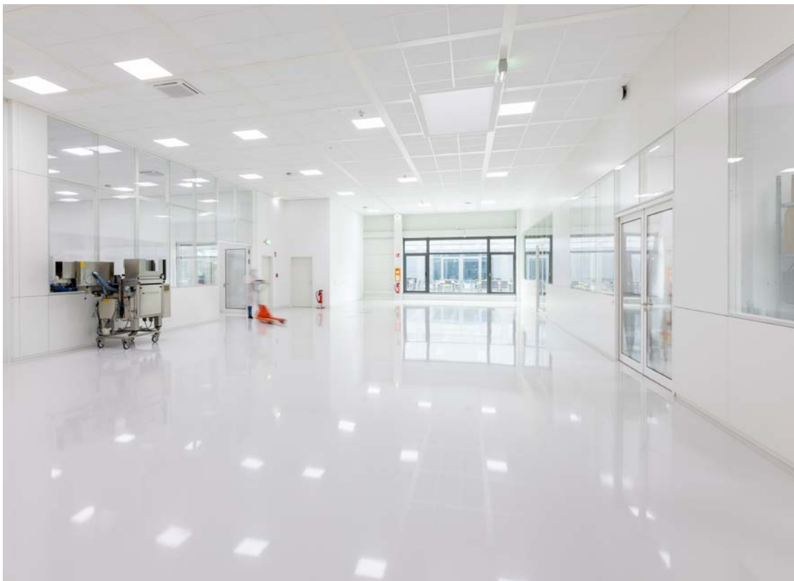
Neubau Produktion und Logistik, Eduard Gerlach GmbH, Lübbecke, DE StoCretec- Kompetenzen: StoFloor Cleanroom KU 601, StoFloor ESD KU 611 Foto: MT-Fotos
